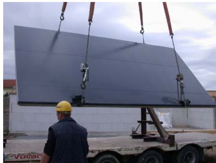
Bild 3: iRoof-Oberschale ohne PV, BVH Oberhausen
