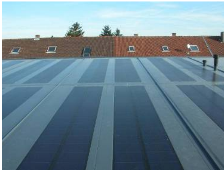
Bild 6: iRoof-Dachansicht, BVH Oberhausen
