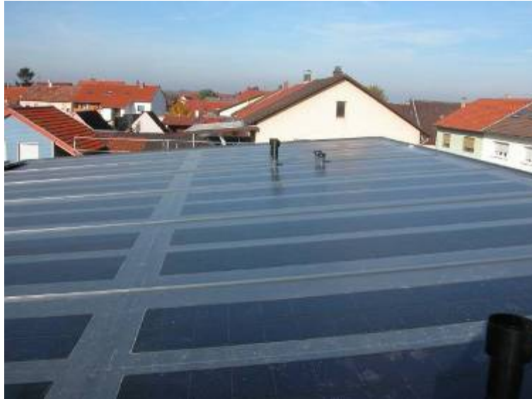
Bild 5: iRoof-Dachansicht, BVH Oberhausen
