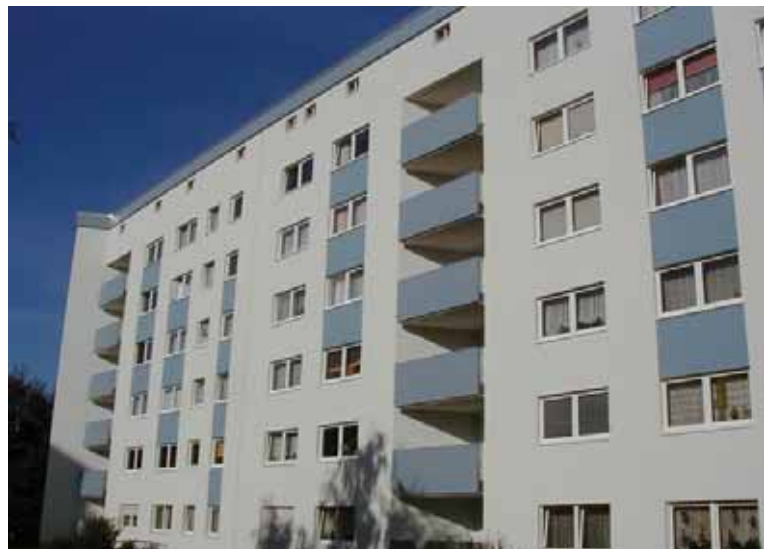
Solarkollektoren auf den Dächern (oben) und Ansicht nach der Sanierung (unten)
