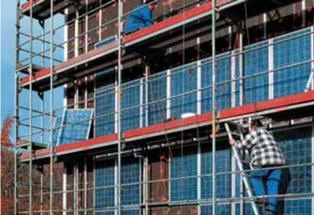
Montage der fassadenintegrierten PV-Module (LEG)
