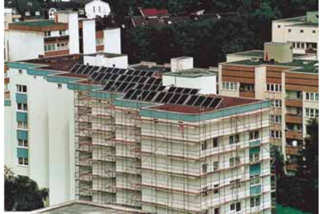
Sanierung der Gebäudegruppe Georg-Kaiser-Straße (ASG)
