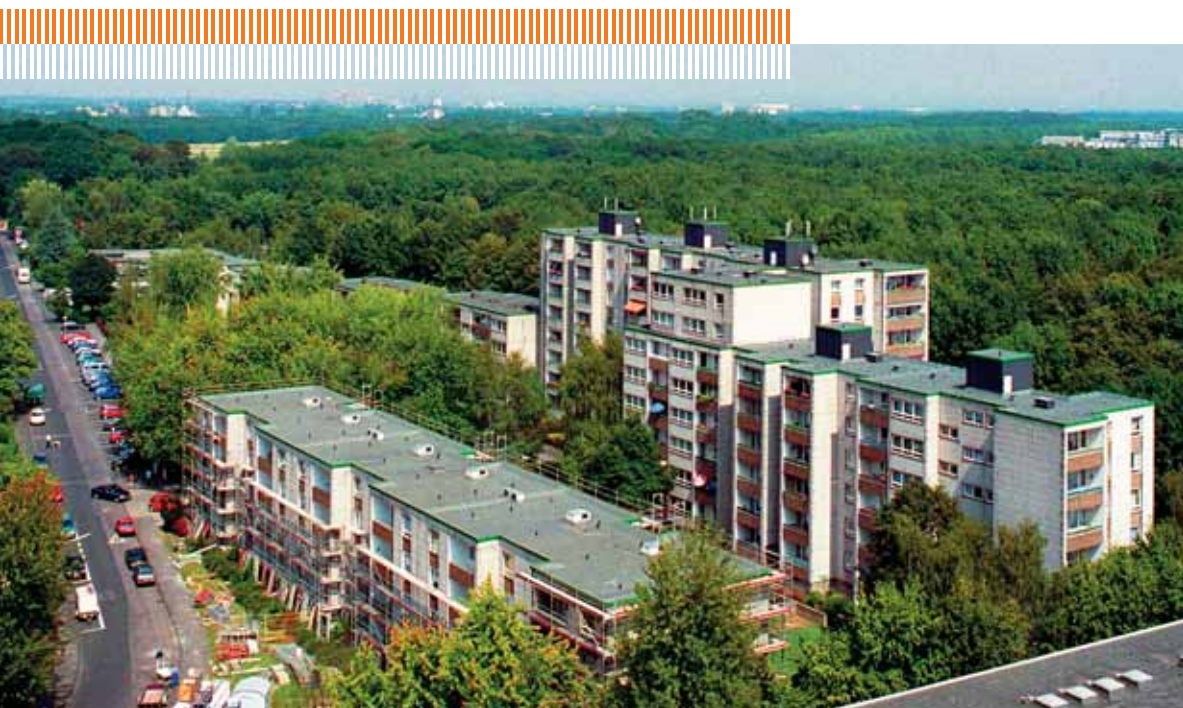
Die Gebäude der LEG am Schumacherring vor den Modernisierungsarbeiten
